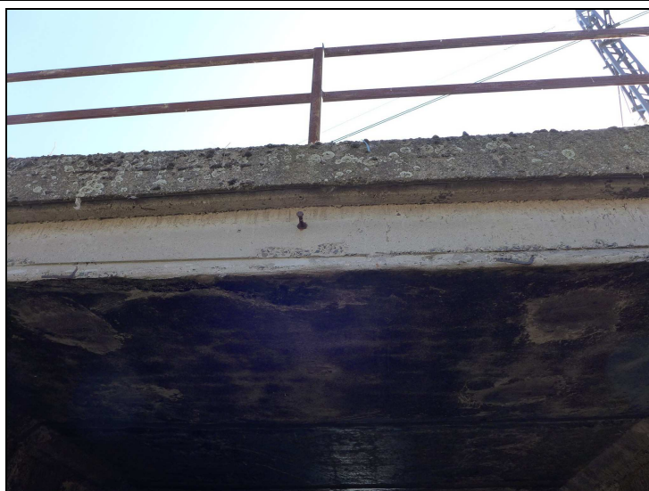
2. K 01 čelo vpravo – degradace betonu římsy
