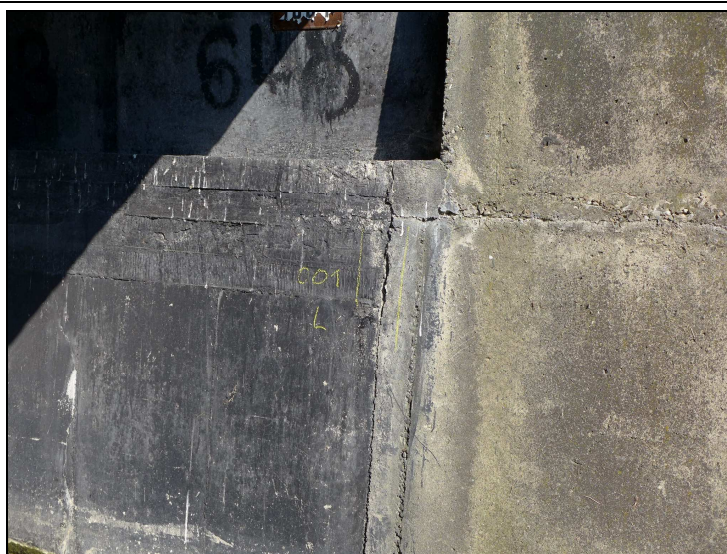
3. O 01 křídlo vlevo – svislá trhлина v napojení křídla na obetonování opěry
