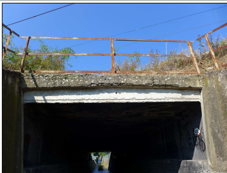
1. K 01 čelo vlevo – degradace betonu římsy
